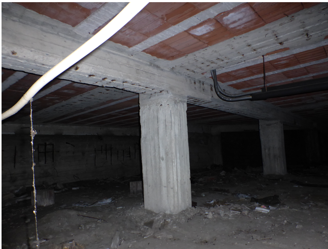
Fig. 6 - foto intradosso primo impalcato
