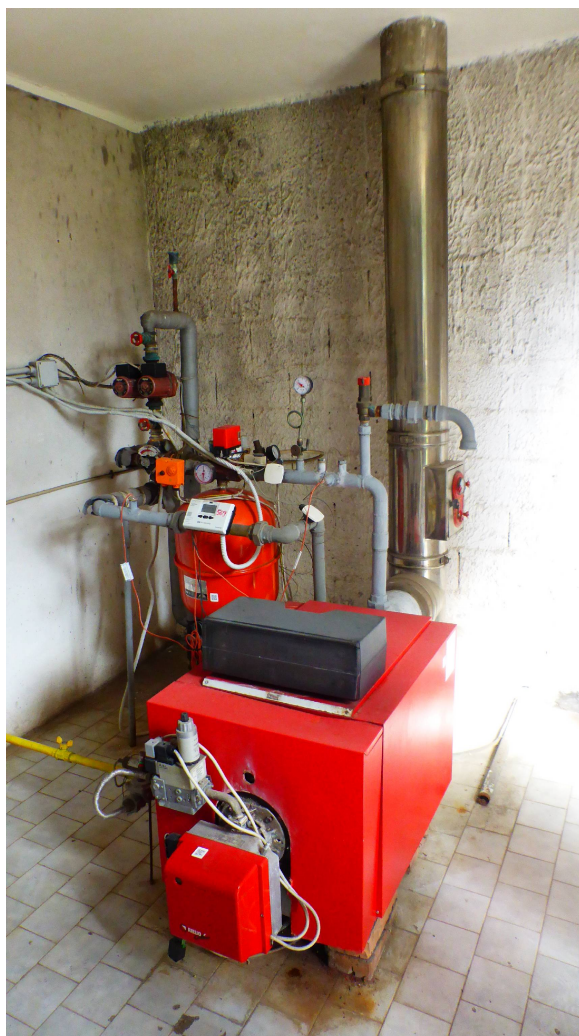
Fig. 13 - generatore a gas
