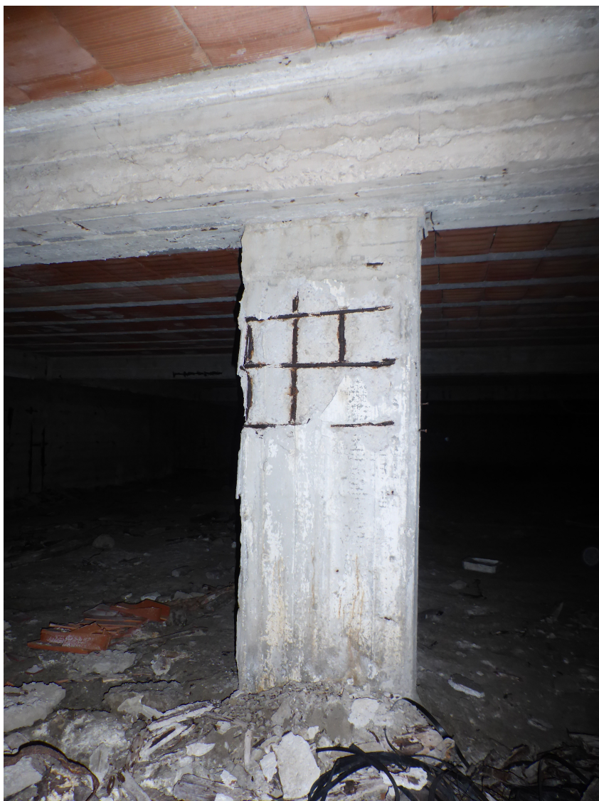
Fig. 7 - degrado pilastro 1° ordine
