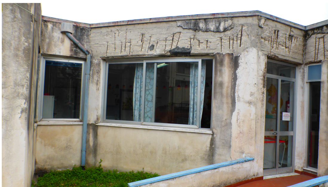
Fig. 8 - degrado trave di bordo 2° impalcato lato sud
